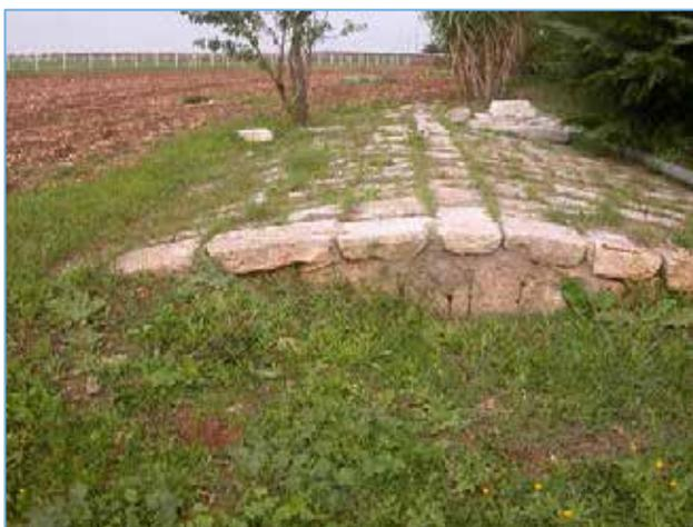
**Foto 3. Una cisterna di acqua, tradizionalmente utilizzata per la raccolta delle acque piovane da destinare all'irrigazione.**
